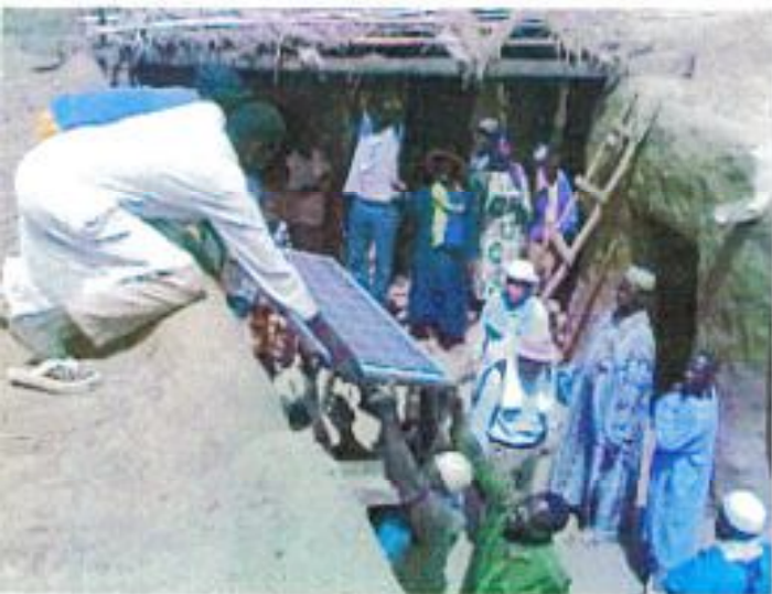
ソーラーパネルを屋上に設置。
